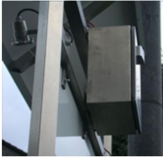
**Die Regeleinheit** Um das Zusammenspiel zwischen dem Photovoltaik-Modul, der Batterie und den HED-Leuchten zu regeln, ist eine Regeleinheit notwendig. Diese befindet sich auf der Rückseite des Firmenschilds und ist gut geschützt vor Wind und Wetter untergebracht.
