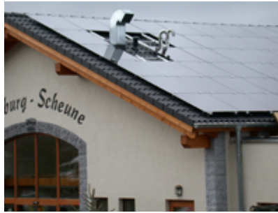
Mikromorphe Anlage - 23,13 kWp
